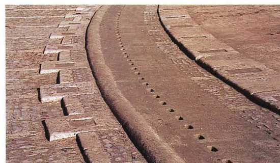
Vista parcial del pavimento en este recinto
