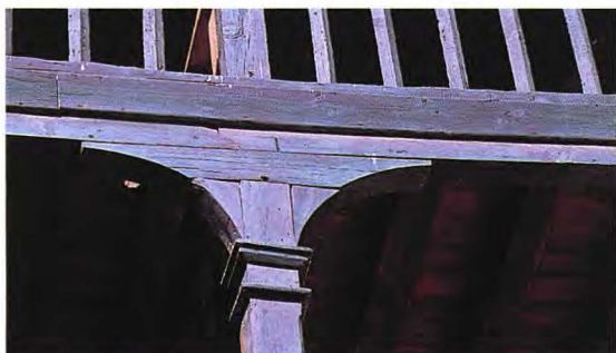
Detalle de pie y zapata tras las obras de restauración
