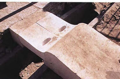
Detalle de las canaletas para la recogida de agua
